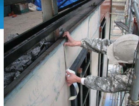
下地鉄骨隙間 処理・塗装工事
