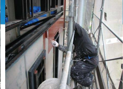
下地鉄骨隙間 処理・塗装工事
